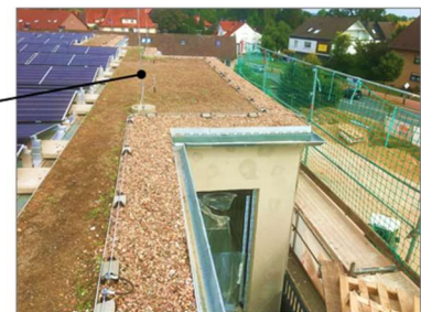
Beispiel für PV-Anlage und Dachbegrünung (Referenz: iNeG)
